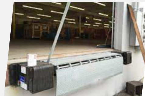
Nachher: Der Ladedock schließt bündig ab und ist mit Markierungen versehen, die ein Übersehen verhindern sollen.
