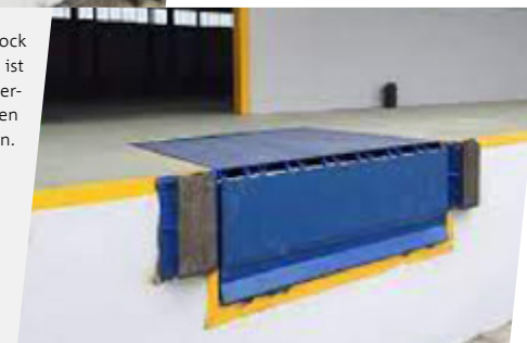
Vorher: Der Ladedock schließt nicht bündig ab und ist nicht gekennzeichnet.
